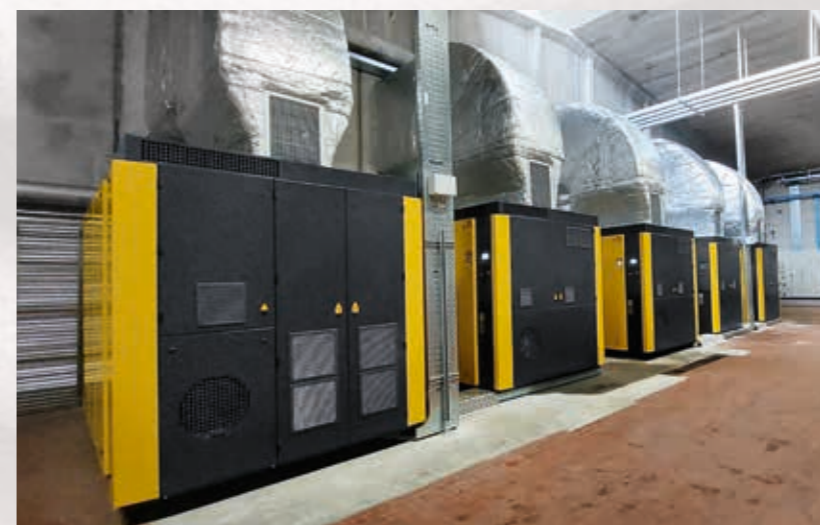
Foto links: Cervotessile staat bekend om hun hoogwaardige producten en blijven hier geschiedenis mee schrijven. Foto rechts: het nieuwe persluchtstation bestaat uit vijf schroefcompressoren van KAESER.
