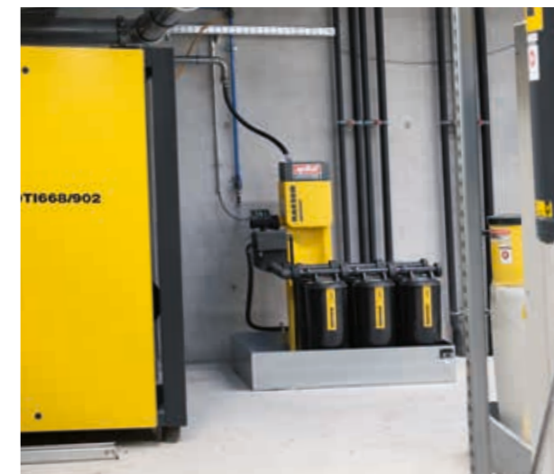
De nieuwe AQUAMAT i.CF is de eerste intelligente olie-water-scheider.
