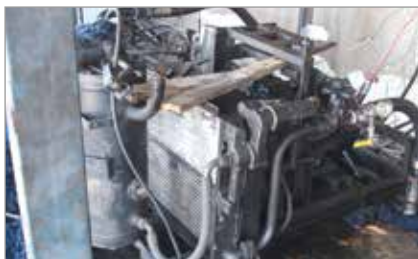
Afb. 1: Verwaarloosd persluchtstation
