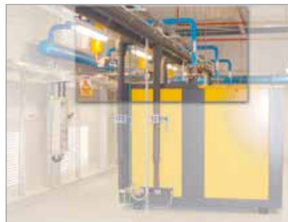
Afb. 3b: Trillingselastische compressoraansluiting met axiale compensatoren
