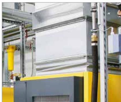
Afb. 2: Ventilatieaansluiting van de compressor met elastische verbinding
