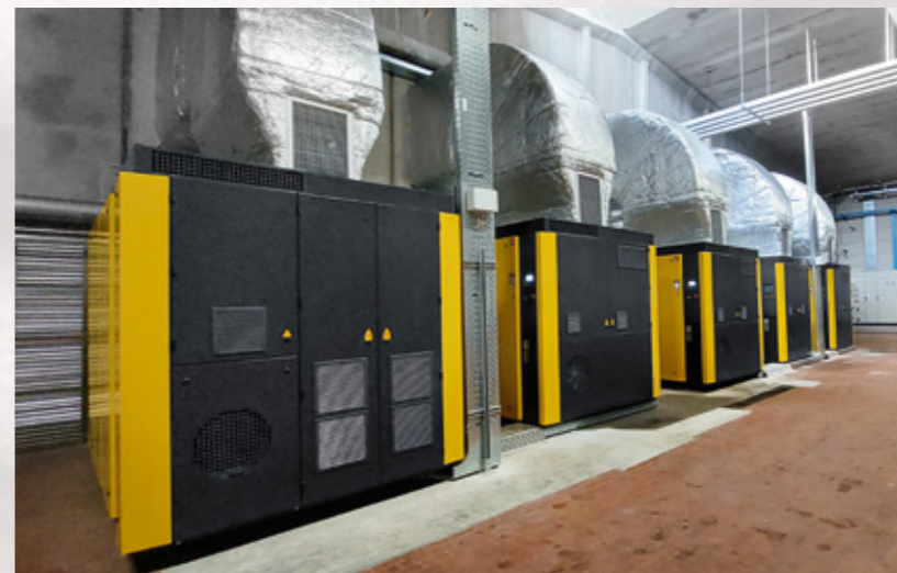
Photo de gauche : Cervotessile est réputé pour ses produits haut de gamme. Photo de droite : La nouvelle station d'air comprimé constituée de cinq compresseurs à vis KAESER.
